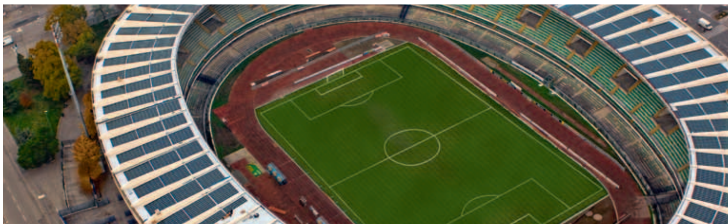
Stadio Bentegodi - copertura FV di AGSM - Verona Progetto di JUWI - Pannelli First Solar
