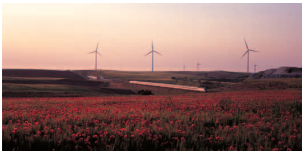
Impianto eolico, Comune di Poggio Imperiale
