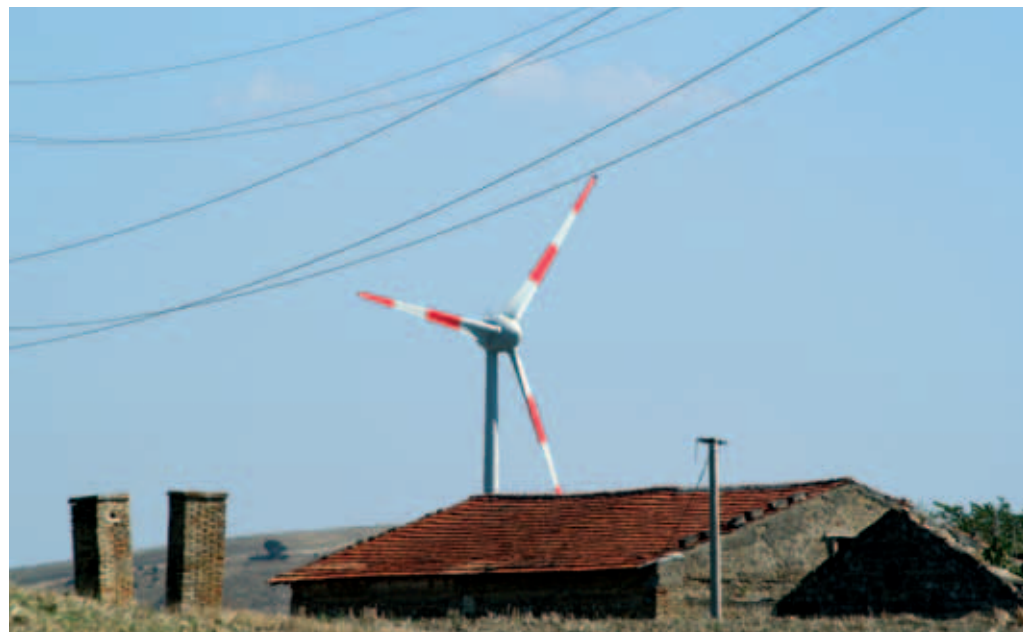
Impianto eolico Comune di Candela (Fg)
