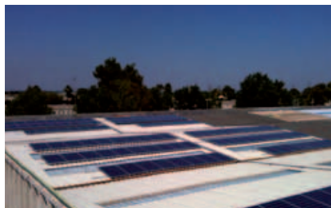
Impianto fotovoltaico su capannone industriale, Comune di Casamassima (BA)
