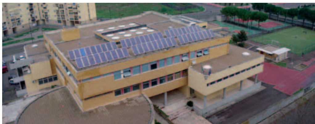
Impianto solare termico su scuola media Comune di Lecce
